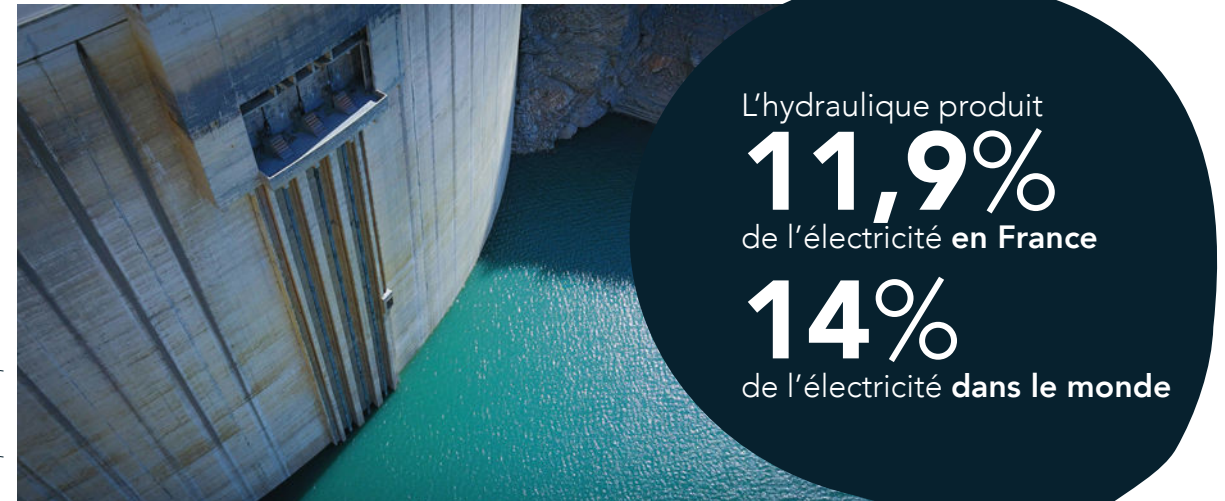
Barrage de Tignes, situé en Savoie ; c'est le plus haut barrage hydroélectrique de France : 180 m de hauteur.
